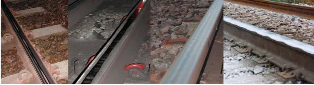
Şekil 11: Raylarda Oluşan Ondülasyonalar
